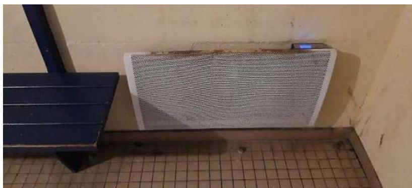
Radiateur électrique avec traces de rouilles
